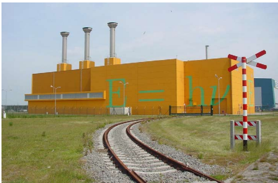
Figuur 2.8.2 Het Hoogactief Afval, Behandeling- en Opslag Gebouw te Borssele.
