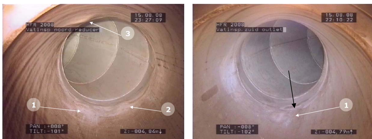
Figuur 2.3 Deformaties noord en zuid reducer
