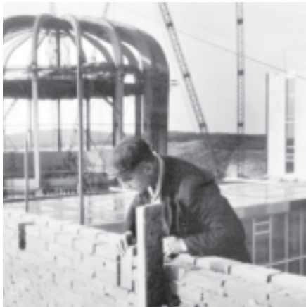
De Hoge Flux Reactor bij Petten in aanbouw (1958)
