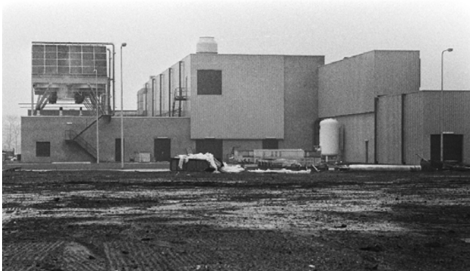
UCN Almelo in aanbouw, 1976
