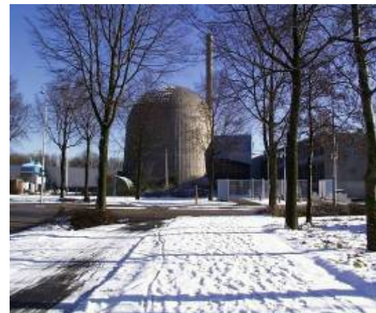
HOR Reactor Instituut Delft
