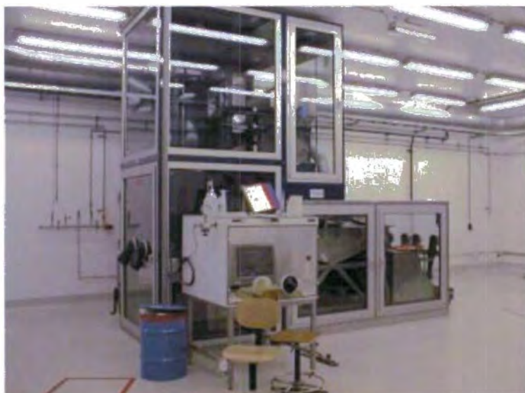
Figuur 6.9: Maalinstallatie voor de verwerking van telpotjes
