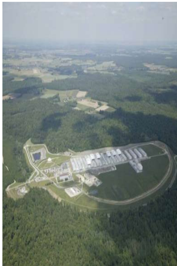
Le centre de stockage FAMA de l'Aube
