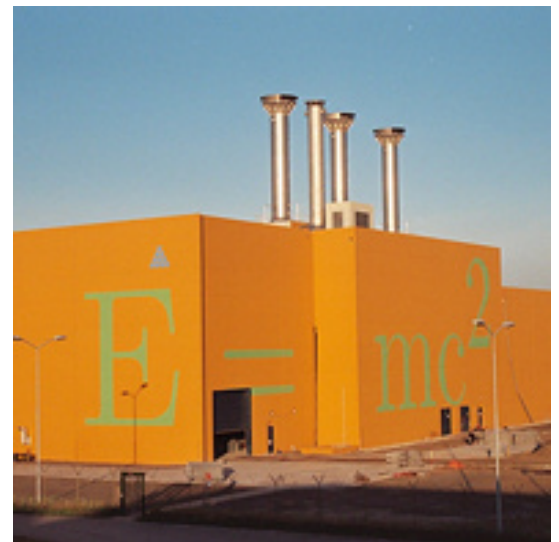
Figuur 4.5 Opslaggebouw voor Hoogradioactief afval bij COVRA. Bron: RIVM
